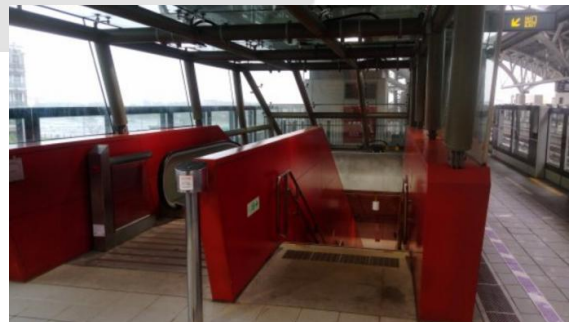
圖 11 機場捷運月台層電扶梯防風雨保護
