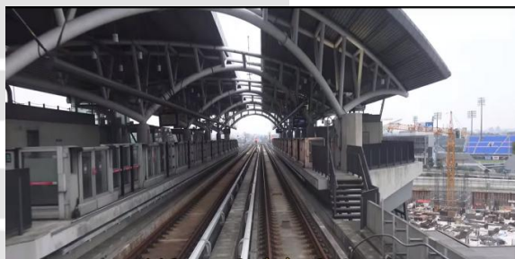
圖5 機場捷運側式月台站遮簷出挑防風雨
