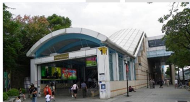
圖2 高架車站出入口設置遮棚區域、側邊設置圍絕阻隔避風雨
