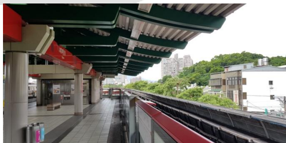
圖6 臺北捷運島式月台站遮簷出挑防風雨
