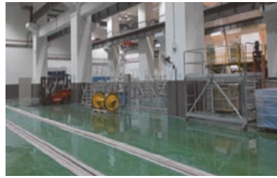
圖 31 廠房內埋入式軌道
