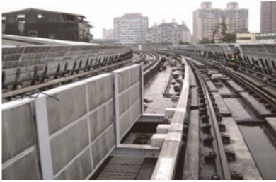
圖 27 高架段基座式軌道(北捷)
